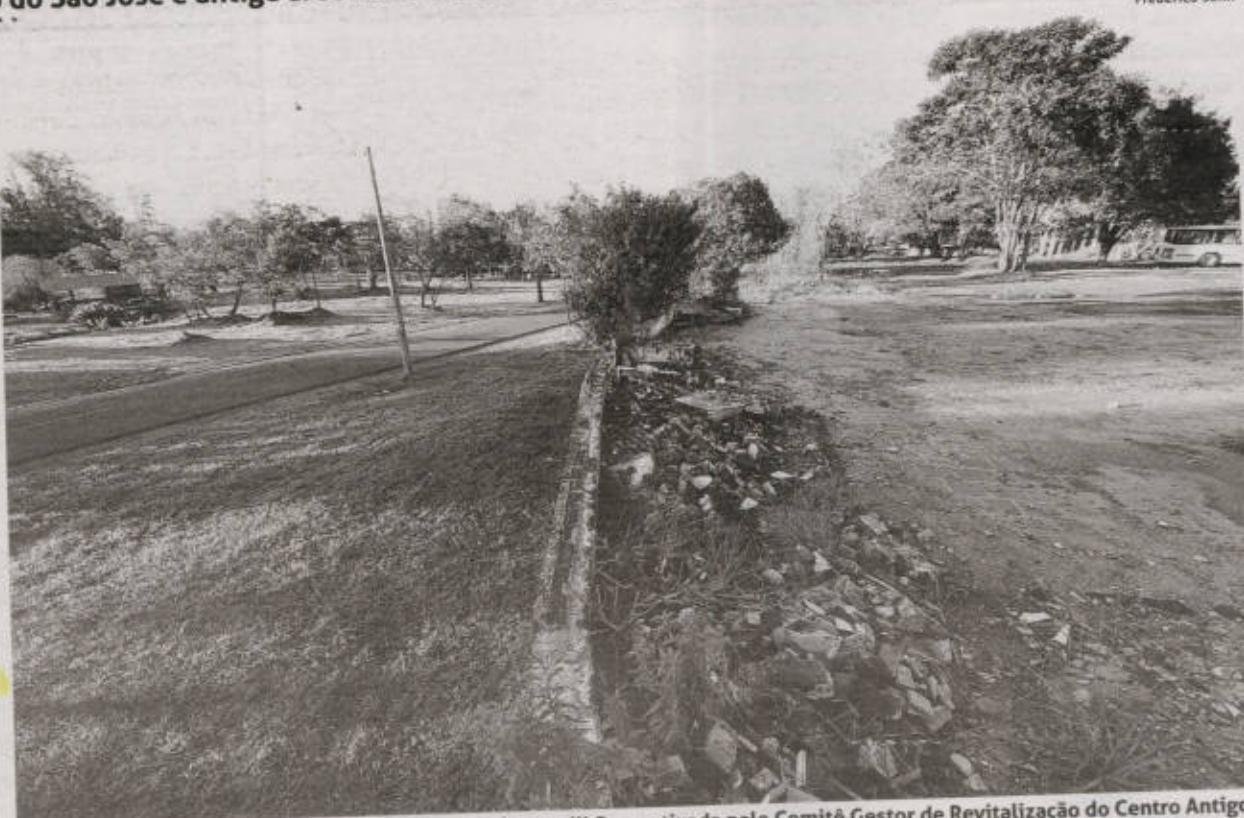
Não há previsão de execução da obra orçada em R$ 1,5 milhão, motivada pelo Comitê Gestor de Revitalização do Centro Antigo
