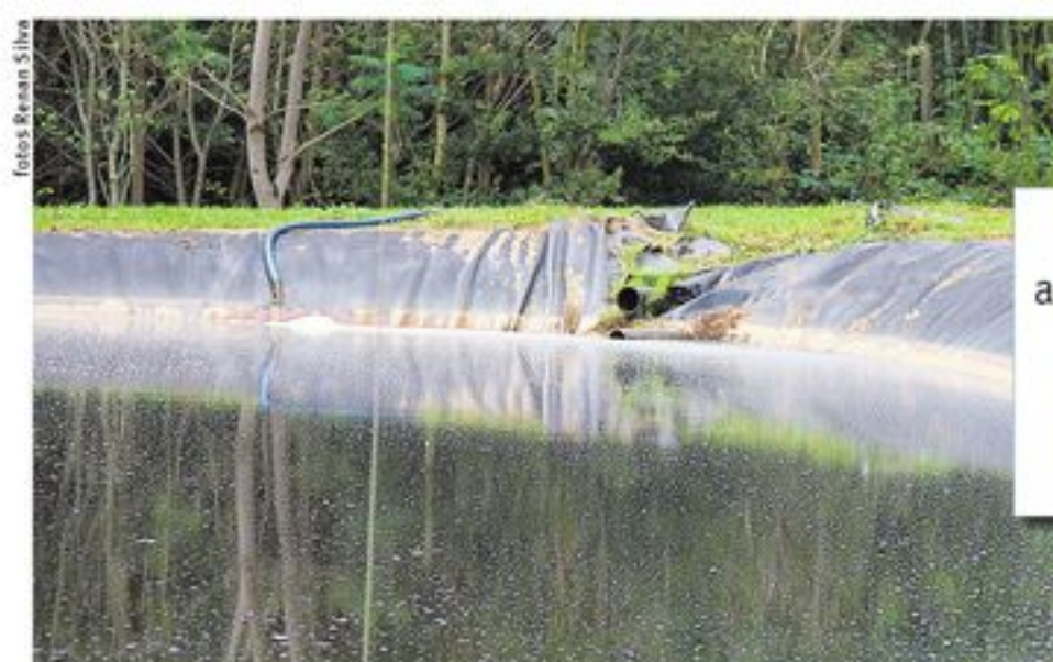
Lagoa anaeróbia: Chorume é decomposto por micro-organismos sem ou quase sem oxigênio molecular
