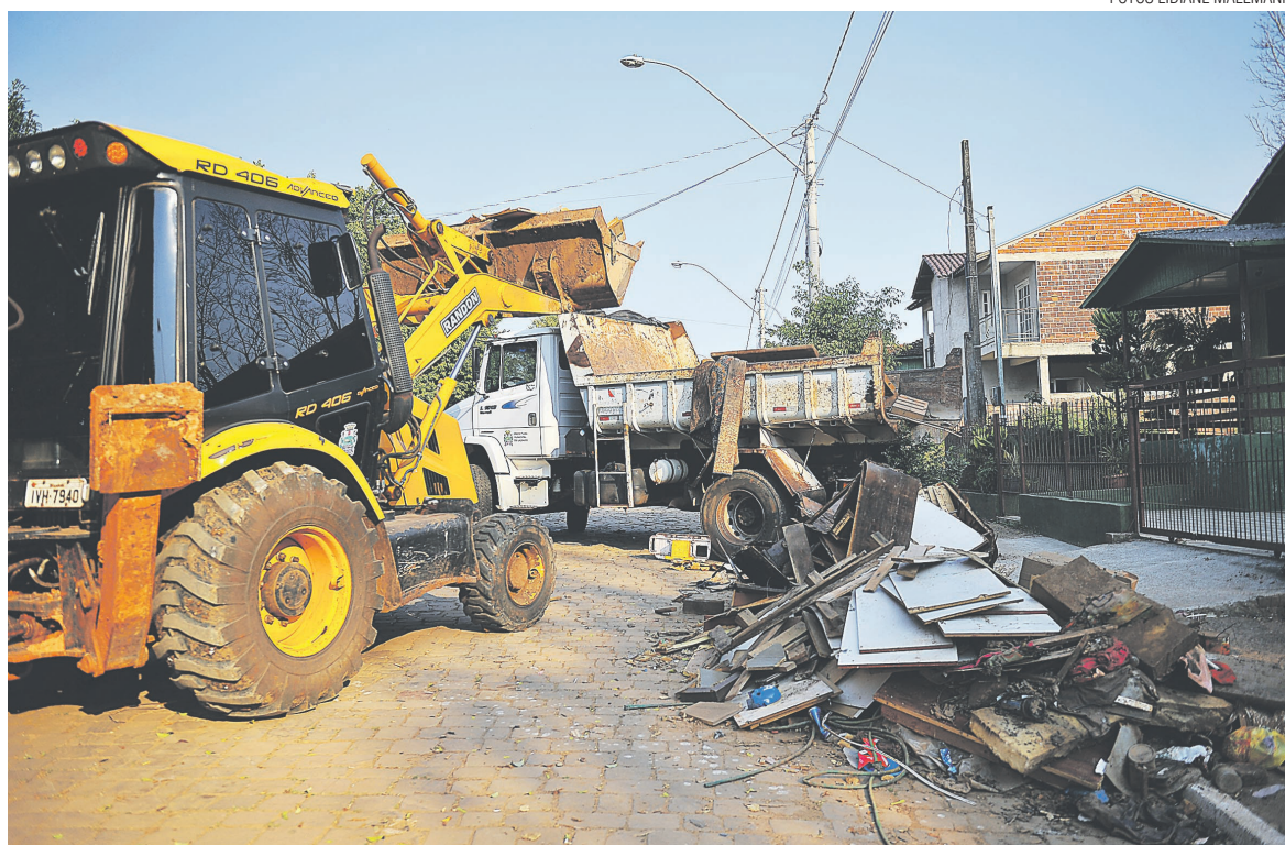
Ontem, servidores municipais realizaram retirada de entulhos no Bairro Praia
