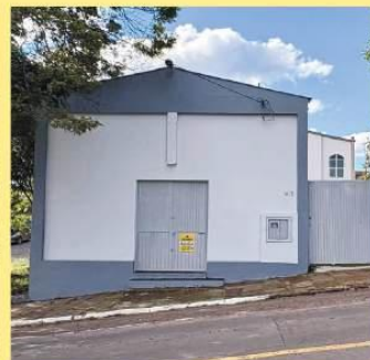
PAVILHÃO - SÃO CRISTÓVÃO
