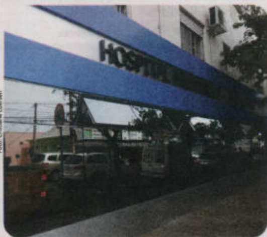
Fachada da nova entrada já está concluída
