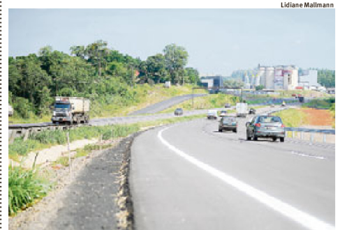
DUPLICAÇÃO: obra deve finalizar com custo de R$ 208 milhões
