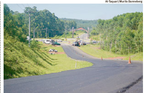
TQ-150: cerca de 7,1 quilômetros foram pavimentados
