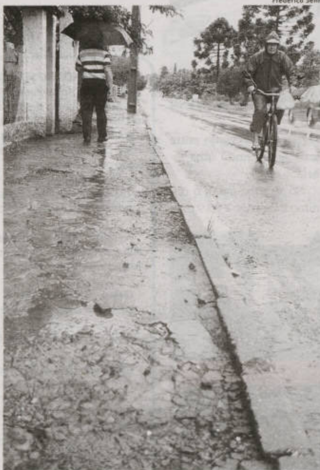
Calçadas do Bairro Conventos serão reformadas
