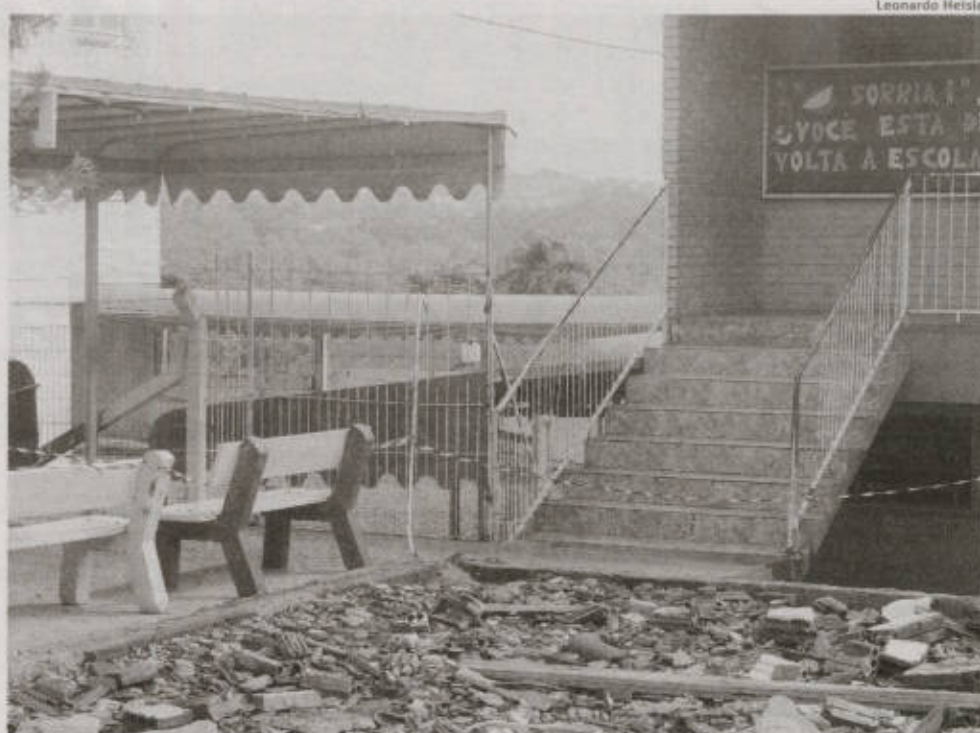
Escola ganhará novo pátio nos próximos dias. Construção de novo prédio depende de liberação
