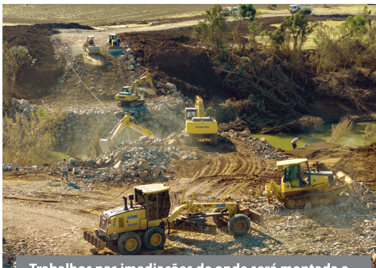
Trabalhos nas imediações de onde será montada a estrutura avançaram nos últimos dias
