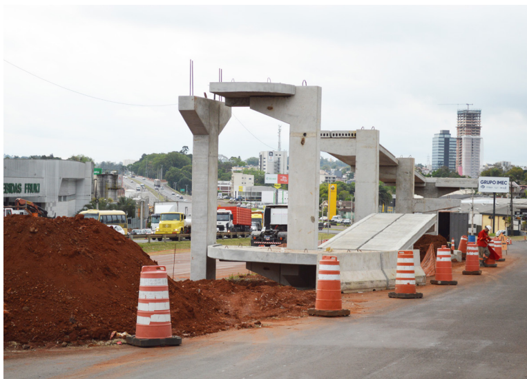
Serviços incluem instalação de duas passarelas na área urbana de Lajeado
