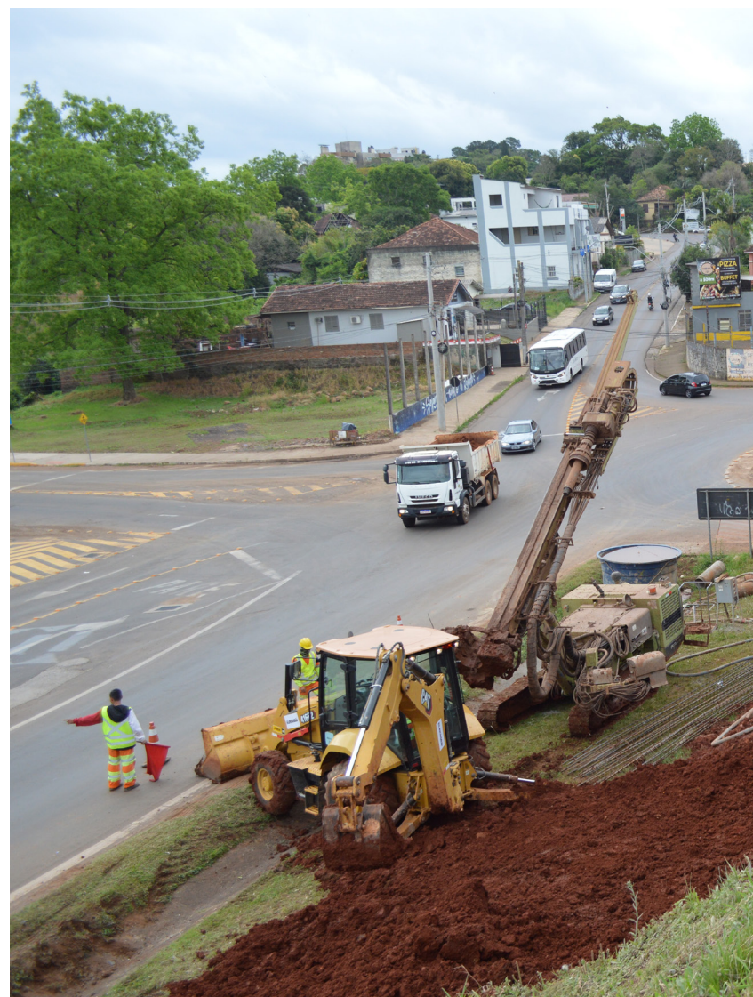
Equipes trabalham em estrutura para alargar viaduto na rua Bento Rosa.
