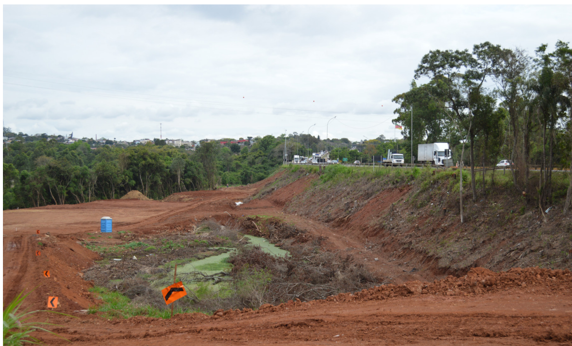
Obra na BR-386 também inclui novo trevo de acesso à ERS-129 no trecho de Estrela
