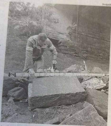
A ação ocorreu na ponte da Várzea, localizada no Bairro Languiru
