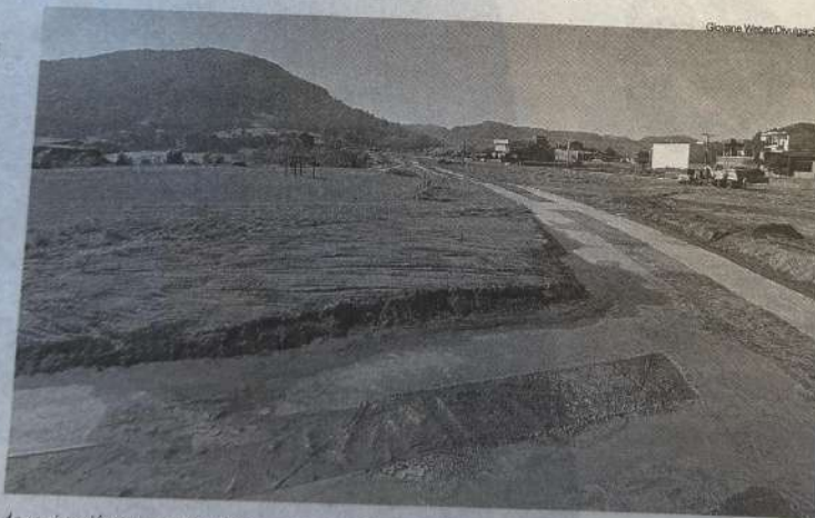
As equipes já atuam na recuperação e construção de novas pistas de caminhada
