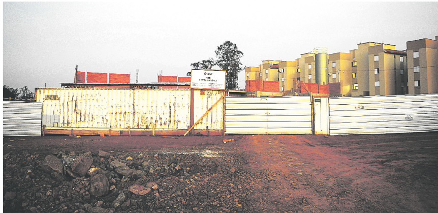
Obras na Emei Santo Antônio estão 40% concluídas. Previsão para o início das atividades é 2020
