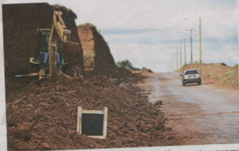
Obra na av. Benjamin Constant, no bairro Moinhos d'Água, continua suspensa
