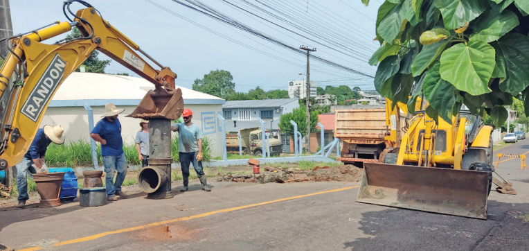
Na rua Otelo Rosa, operários iniciaram a ligação da nova rede
