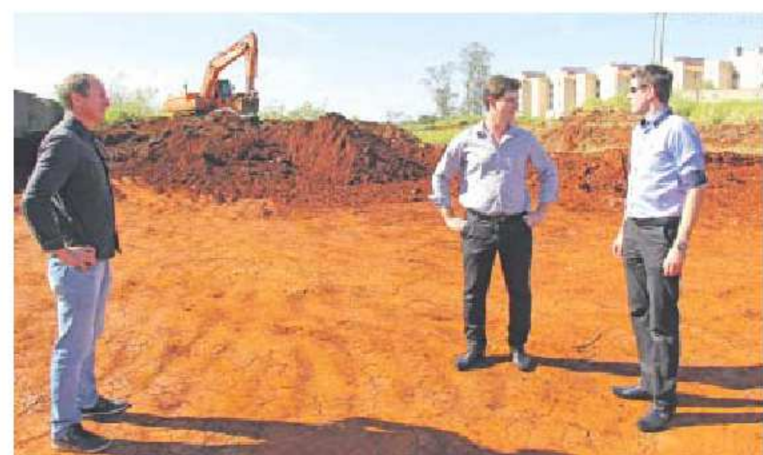
OBRA: Fabiano Bergmann, Marcelo Caumo e Tovar Musskopf no local onde está sendo construído o posto Novo Tempo
