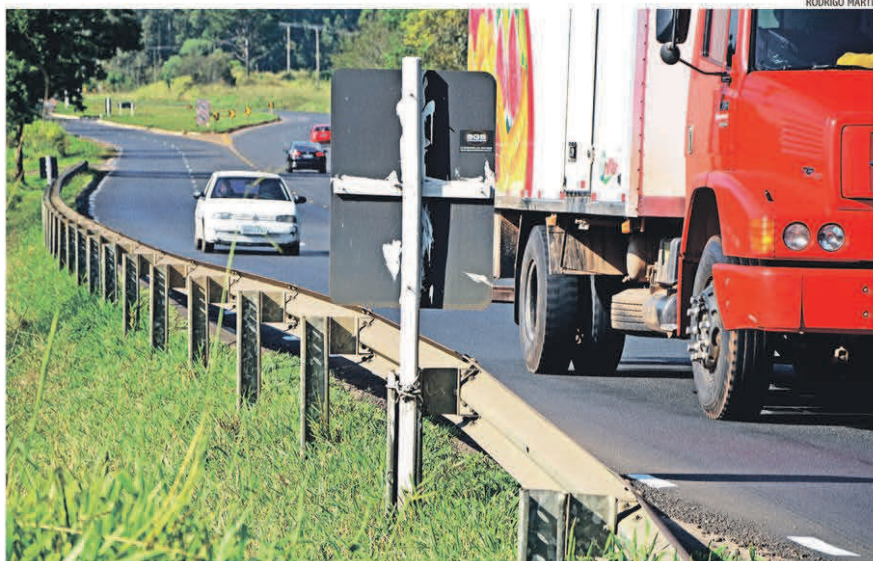
Praça será instalada próximo ao trevo de Paverama, antes da rodovia que leva a Taquari, no sentido interior-capital
