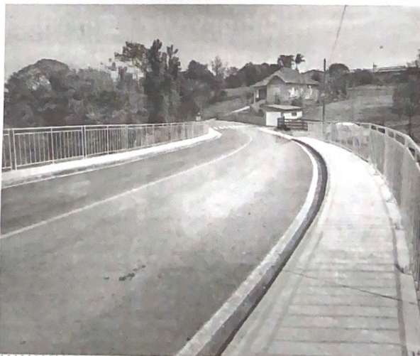
A curva da ponte de acesso à Westfália também recebeu calçada de passeio e guarda-corpo
