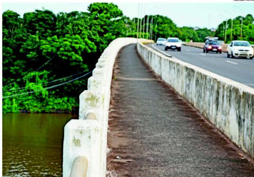
Pontes no quilômetro 348 da rodovia federal têm 262 metros de extensão. Obra da nova estrutura pode iniciar em 2034
