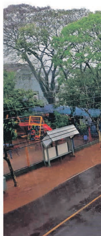
Bueiros transbordaram na av. 28
