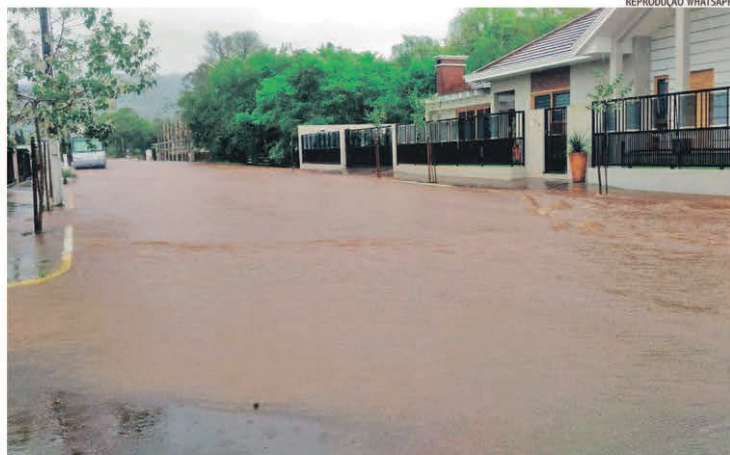
No loteamento Sete de Setembro, ruas se transformaram em arroios e água invadiu pátios
