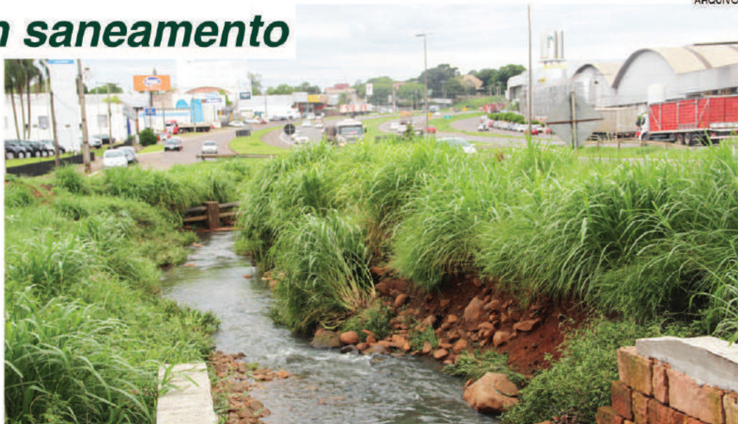
Arroio do Engenho virou esgoto a céu aberto. No verão, população sofre com mau cheiro no local
