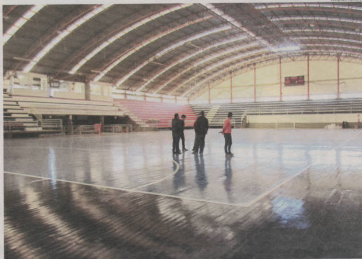
Reformas no Claudião devem ser concluídas nas próximas semanas. Vistoria da quadra ocorre na manhã de hoje
