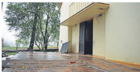
Rampa foi construída para facilitar o acesso dos fiéis à igreja
