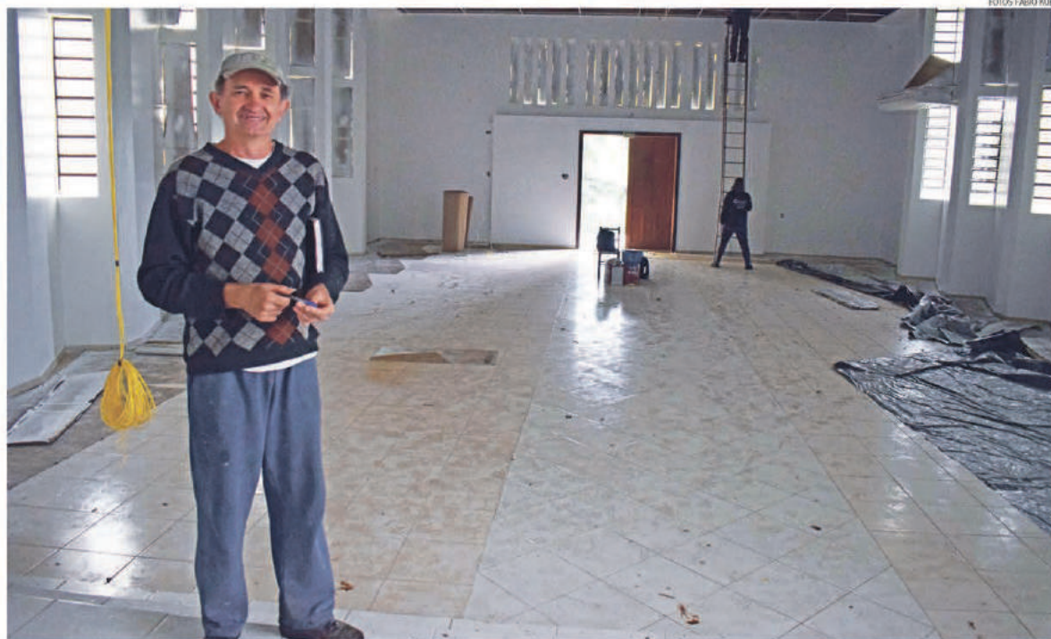
Igreja está em reformas faz três meses. Diretoria quer finalizar parte da obra até o dia 10, data do tradicional jantar-baile do Olarias
