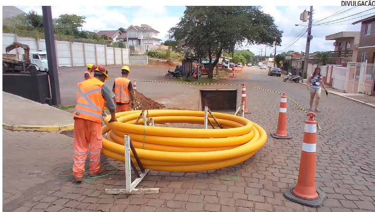
Instalação do ramal de gás natural em Lajeado foi concluída em março. Sulgás promove hoje palestra a profissionais da construção civil e agentes de segurança
