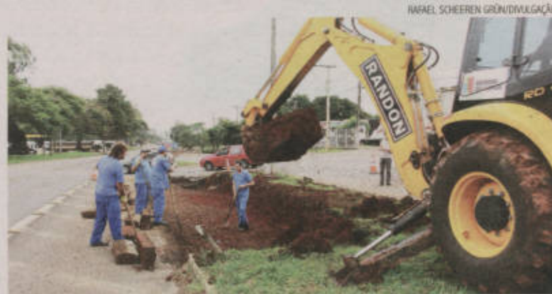
Equipe trabalha no estreitamento do canteiro que separa rodovia de via lateral
