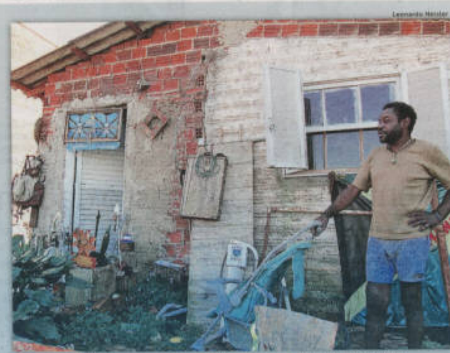
Casa em que Pelezinho mora com o irmão Rogério não tem água, nem eletricidade
