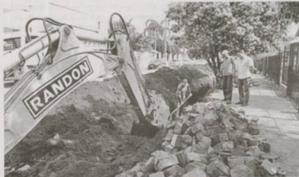
Rua Antônio de Souza Neto, no Bairro Carneiros, recebe canalização pluvial
