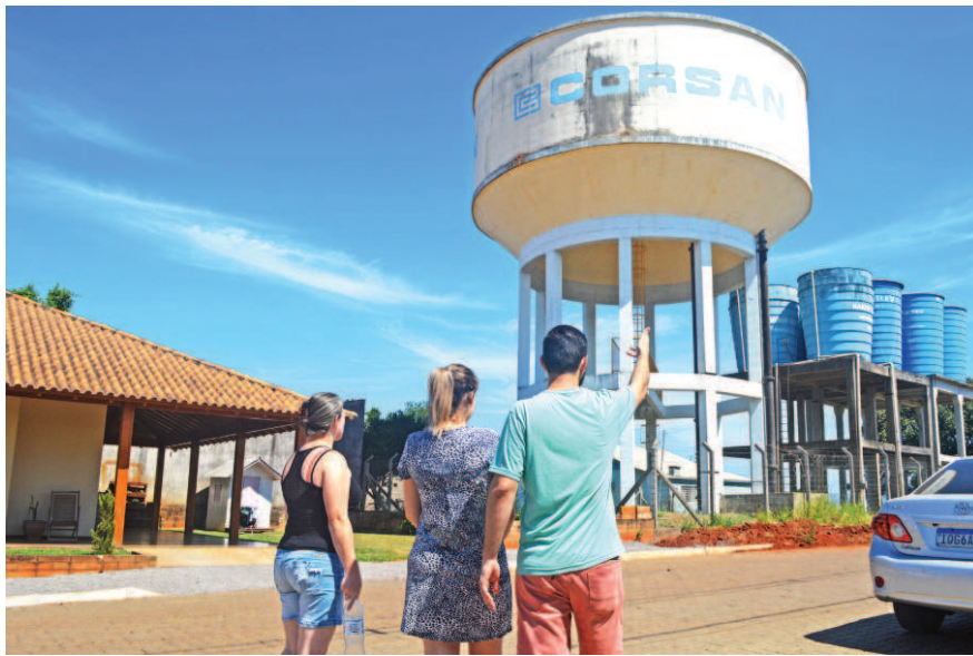
Com casas em frente a reservatório de água, famílias da rua Frederico Arnoldo Weber têm problemas de abastecimento
