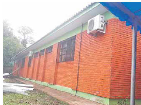
REFORMA: novo telhado permite reabertura e retomada do atendimento
