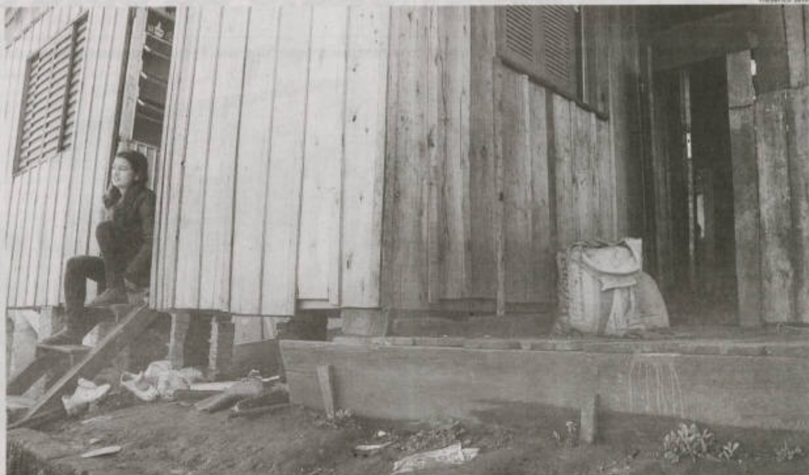
Sem documentos do imóvel, Vânia não consegue água encanada. O banheiro fica a cerca de 20 metros da casa
