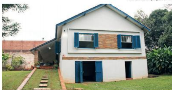
Casa abriga de 15 a 20 pessoas por noite. Albergados também ganham refeição
