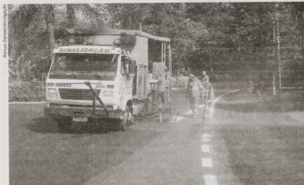
Melhoria está na fase de sinalização e pintura do asfalto, num trecho de cerca de três quilômetros
