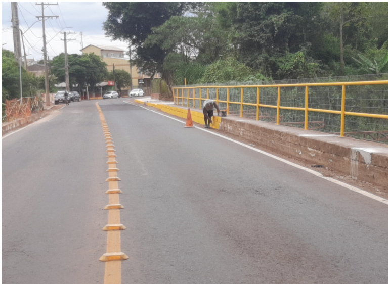
Entre as obras avaliadas, está a pintura no meio-fio da ponte do Saraquá
