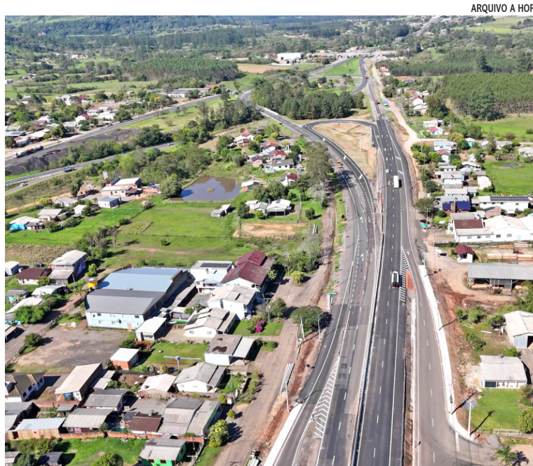
Trecho de Tabai é um dos que passam por obras de duplicação
