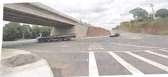
Sinalização foi concluída, facilitando o tráfego de veículos no entorno
