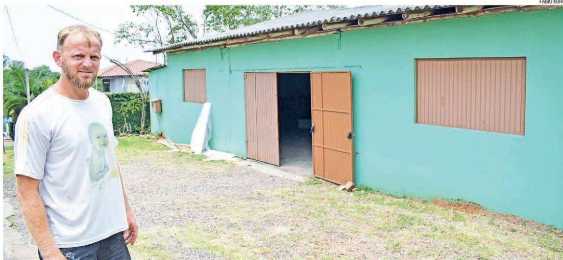
Novo presidente Marcos Johann cita necessidade da troca de telhado e de madeiras infestadas por cupim no salão comunitário do Igrejinha.
