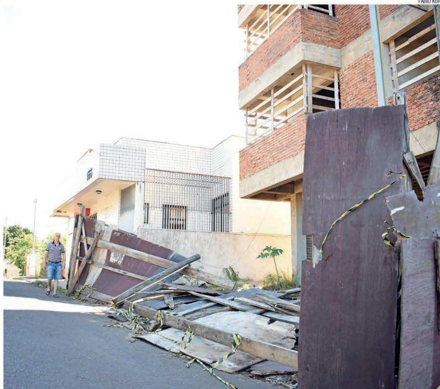
Tapumes foram destruídos por temporal. Moradores como Affonso Schmitz falam dos perigos no local
