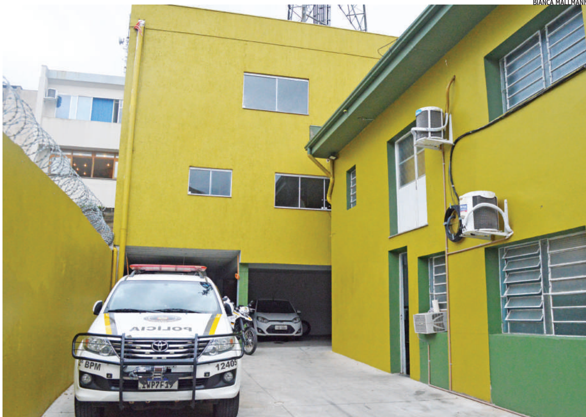
O Centro Integrado fica localizado nos fundos do terreno do 22º BPM da Brigada Militar
