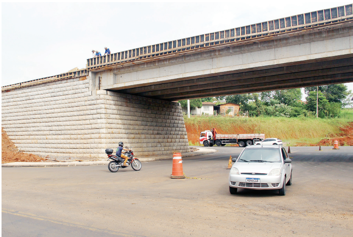
Fluxo de veículos ocorre sob trincheira ainda inacabada. Obra deve ficar pronta até março
