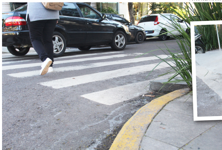
As laterais das rampas são diferentes do que havia sido projetado, avançando além da calçada e sem o desnível
