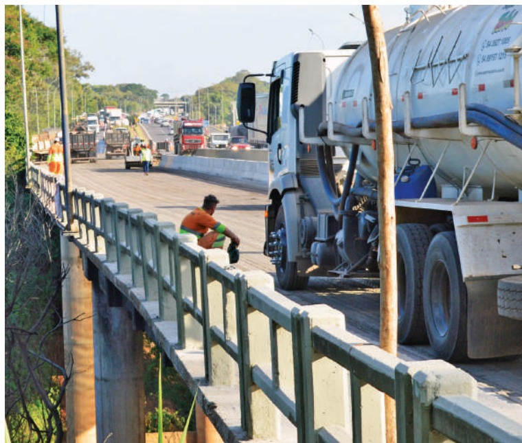
Trabalhos foram intensificados na ponte nas últimas semanas
