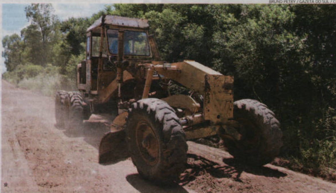
Em Passo do Sobrado, duas patrulas ano 1973, repassadas por Rio Pardo, realizam os serviços nas estradas
