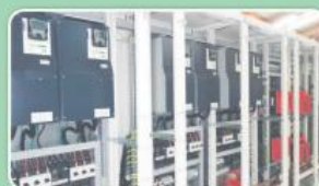
Painéis Elétricos TTA/PTTA NBR IEC 60439-1
