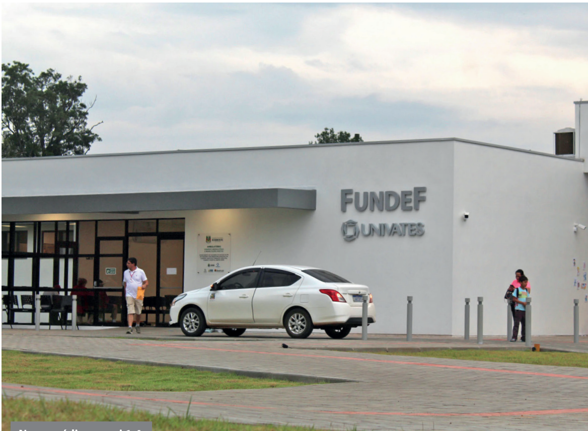
Novo prédio possui 1,4 metros quadrados e permite qualificar os serviços da instituição
