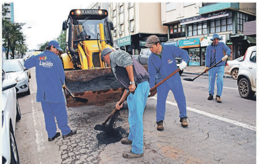
Melhorias nas ruas iniciaram na terça-feira. Avenida Beira Rio é um dos trechos beneficiados com o trabalho
