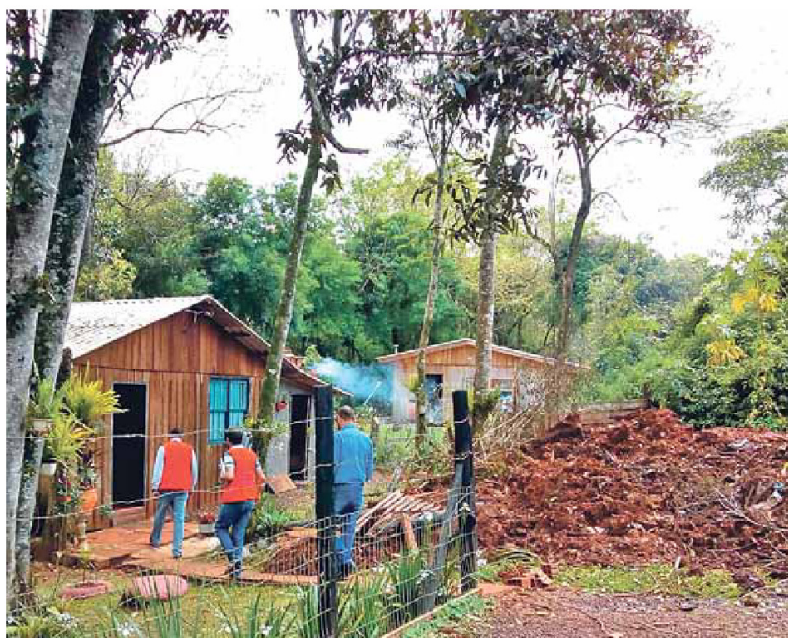
TRAGÉDIA ANUNCIADA: casas estão em área em iminente risco de deslizamento de terra
