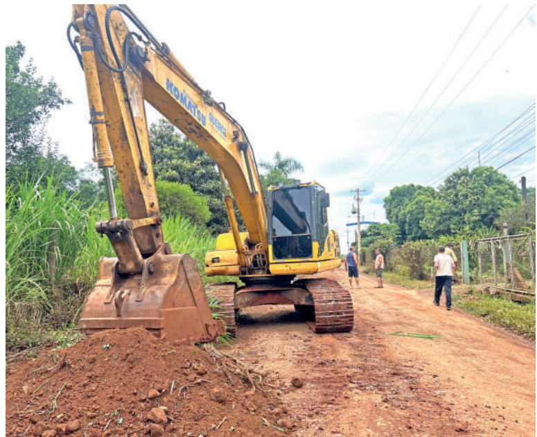
Conpasul trabalha na limpeza da via para dar início à pavimentação
