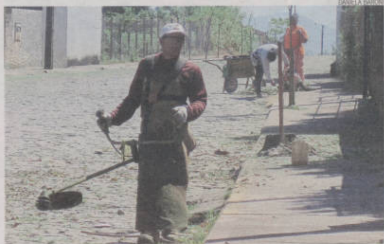
Pedras lançadas pela máquina durante trabalho atingiram uma moradora
