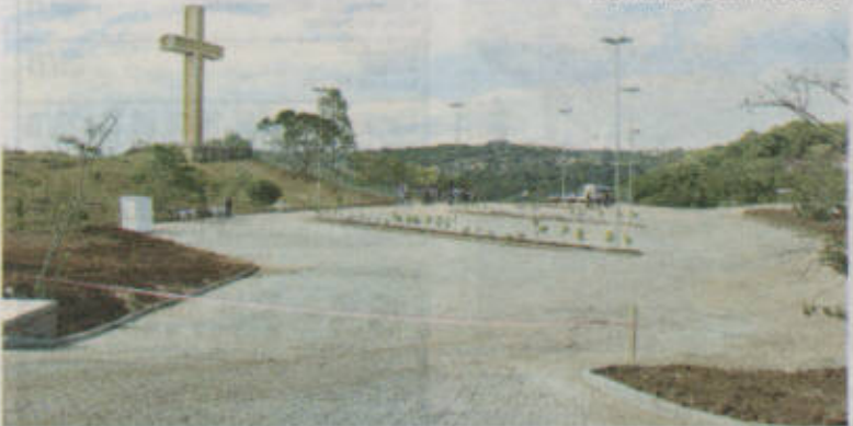
Primeira etapa das obras incluiu melhorias na estrutura e na segurança
