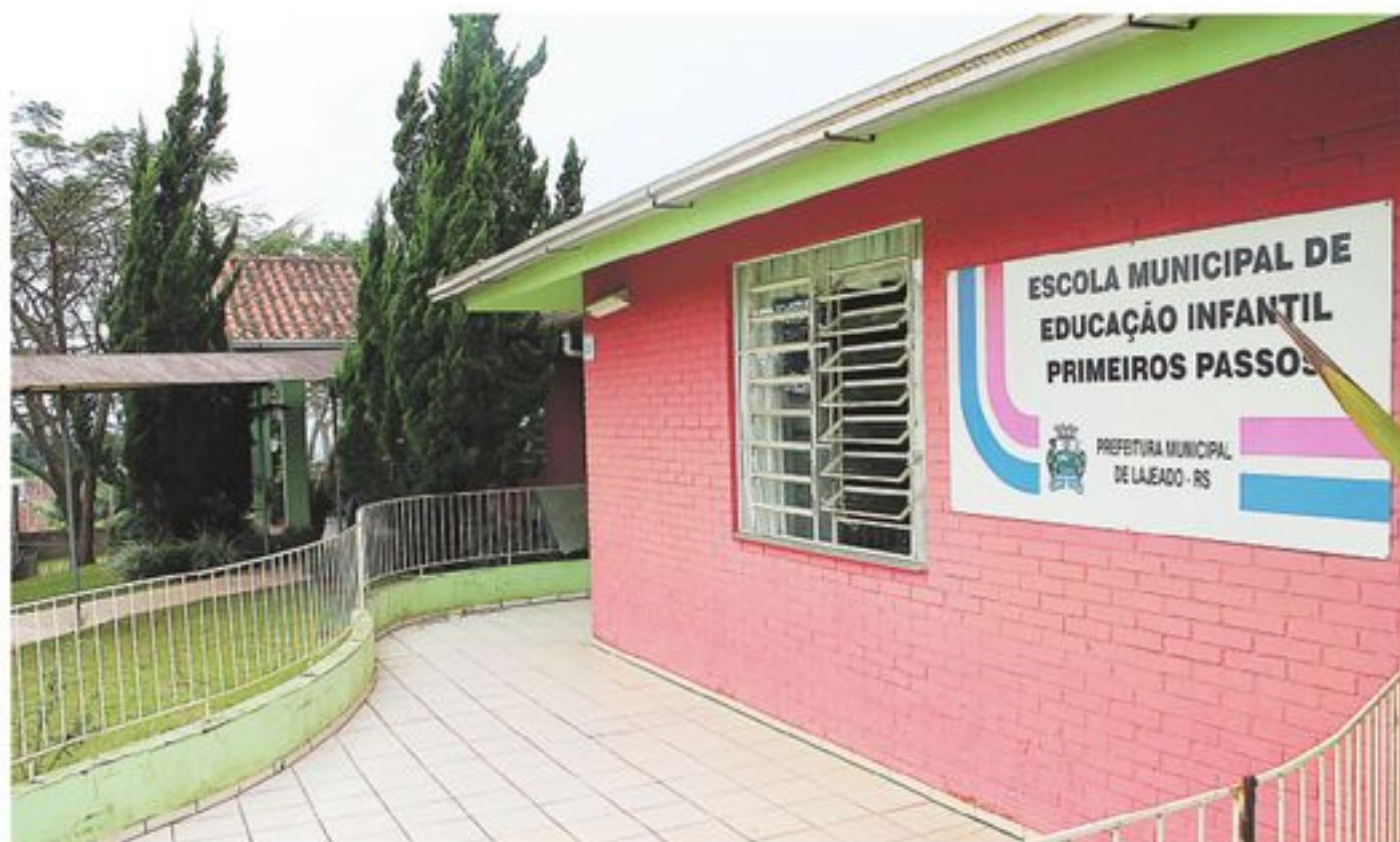
RISCO: após três ameaças de curto-circuito, apenas 18 dos 125 alunos foram à aula ontem
