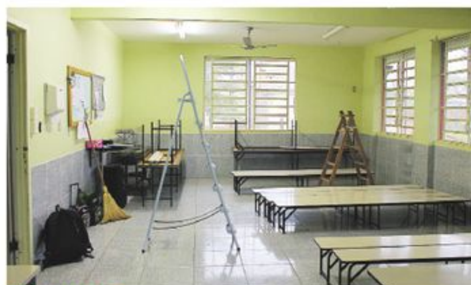
IMPROVISO: com parte das salas "interditada" pelos problemas elétricos, refeitório foi usado para receber estudantes
