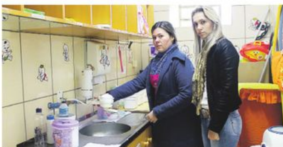
SOBRECARGA: Tatiane e Paula mostram que até ligar a torneira elétrica, no berçário, faz a energia oscilar
