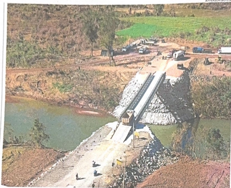
Equipamento foi montado por 90 militares e tem capacidade para suportar até 80 toneladas
