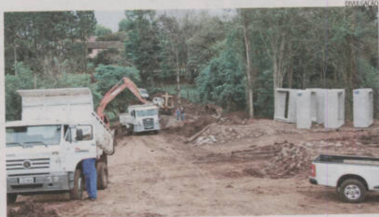
Pavimentação e tubulação pluvial são prioridades no centro e bairros
