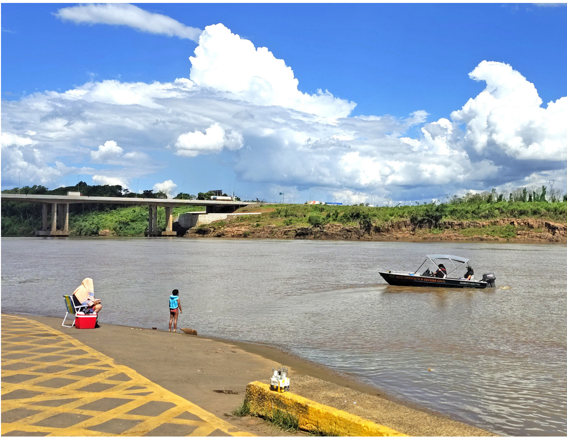
Profundidade na Ponte do Taquari, entre Lajeado e Estrela, oscila de 7 a 12m. Autoridades alertam aos perigos
