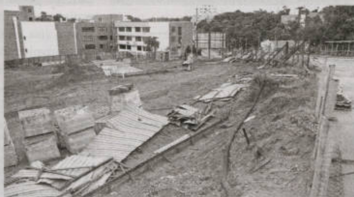
Tapumes da Univates foram arrancados com a força do vento.
