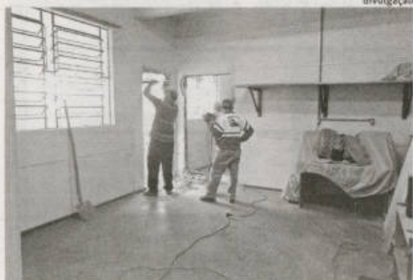
Pais auxiliaram nas obras de ampliação do espaço do berçário
