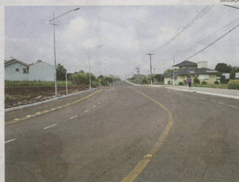
Ciclovias e calçadas serão ampliadas em direção a Vila Cuba
