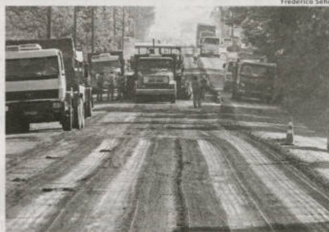
Obras deixaram trânsito lento ontem
