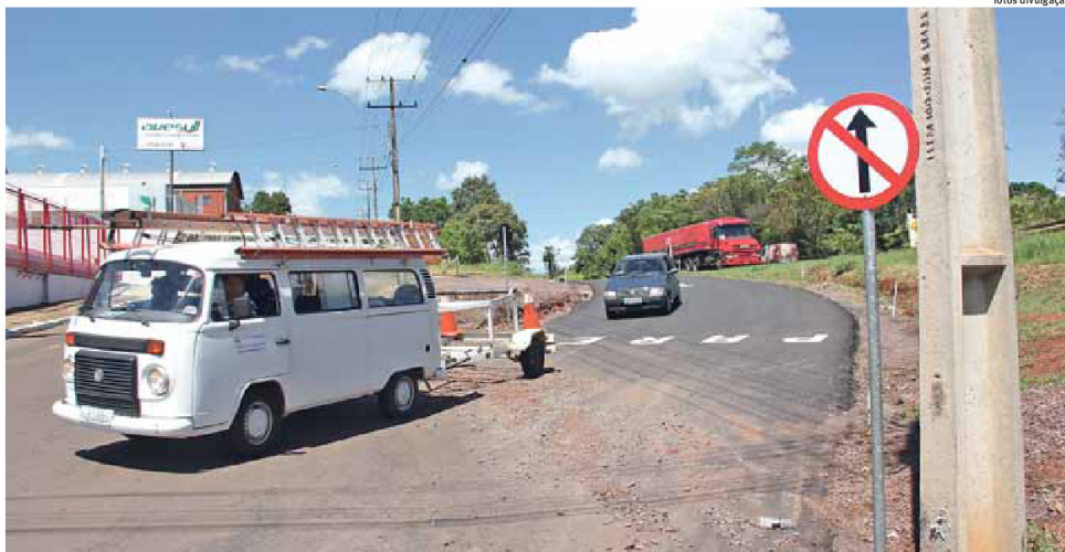
Investimentos em infraestrutura contemplam diferentes bairros, como os do novo acesso ao Bairro Centenário, pela BR-386
